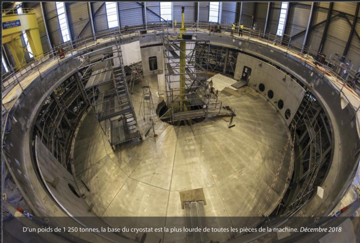
D'un poids de 1 250 tonnes, la base du cryostat est la plus lourde de toutes les pièces de la machine. *Décembre 2018*
