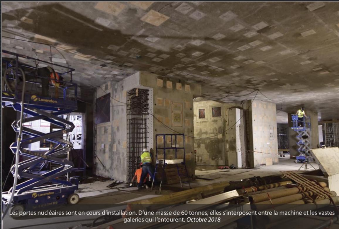
Les portes nucléaires sont en cours d'installation. D'une masse de 60 tonnes, elles s'interposent entre la machine et les vastes galeries qui l'entourent. *Octobre 2018*
