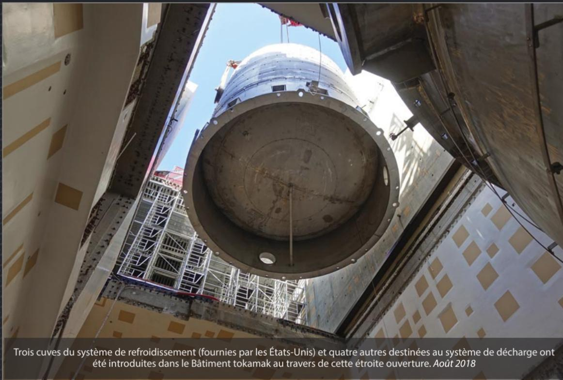
Trois cuves du système de refroidissement (fournies par les États-Unis) et quatre autres destinées au système de décharge ont été introduites dans le Bâtiment tokamak au travers de cette étroite ouverture. Août 2018
