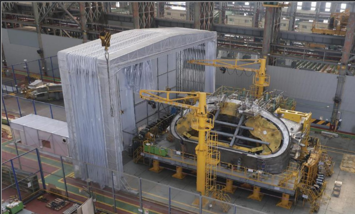
La Corée fournit 4 des 9 secteurs de la chambre à vide du tokamak. La fabrication du secteur n°6 (le premier) approche de son terme au chantier naval de Hyundai Heavy Industries à Ulsan.
