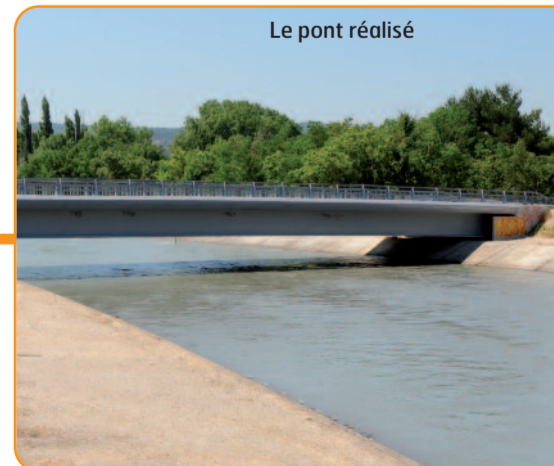
Le pont réalisé
