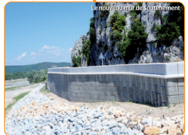
Le nouveau mur de soutènement
