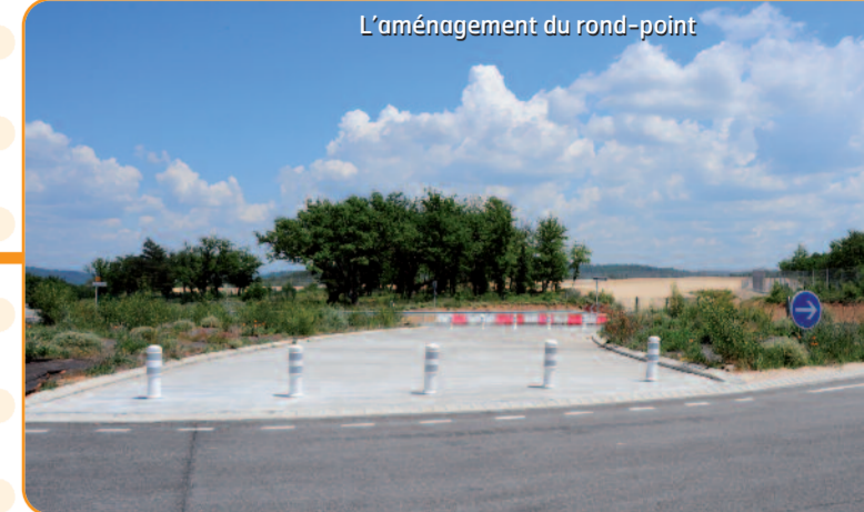
L'aménagement du rond-point
