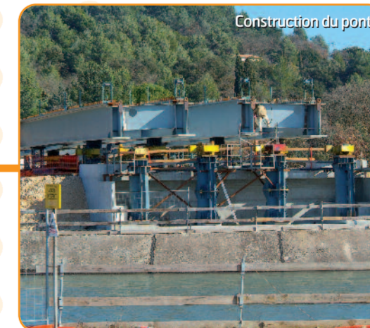
Construction du pont
