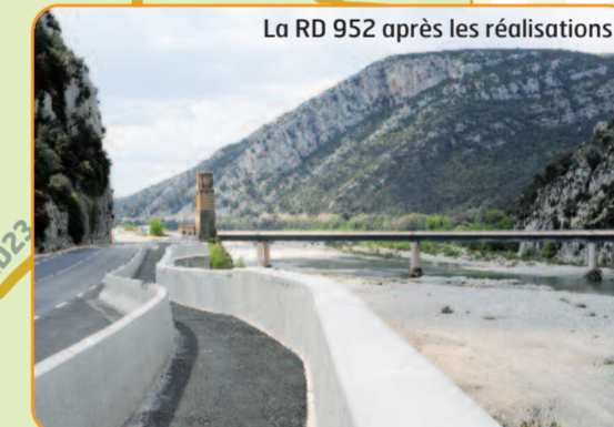
La RD 952 après les réalisations
