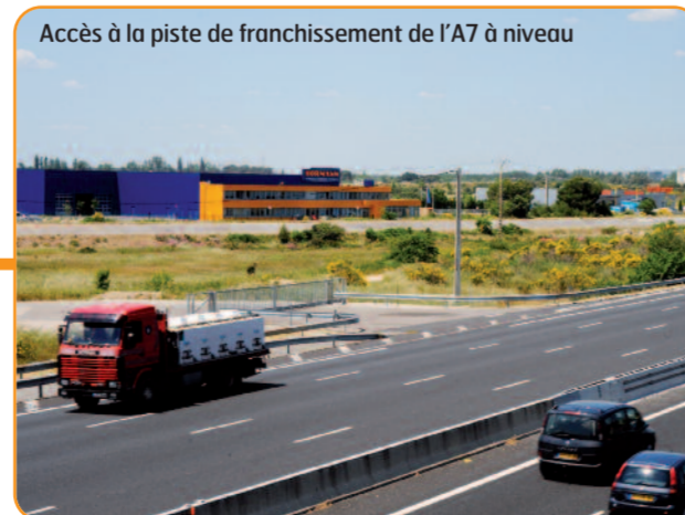
Accès à la piste de franchissement de l'A7 à niveau
