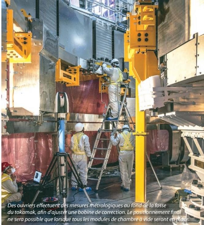
Des ouvriers effectuent des mesures métrologiques au fond de la fosse du tokamak, afin d'ajuster une bobine de correction. Le positionnement final ne sera possible que lorsque tous les modules de chambre à vide seront en place.
