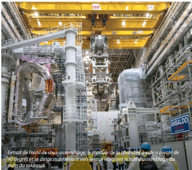
Extrait de l'outil de sous-assemblage, le module de la chambre à vide a pivoté de 90 degrés et se dirige maintenant vers le mur séparant le hall d'assemblage du puits du tokamak.
