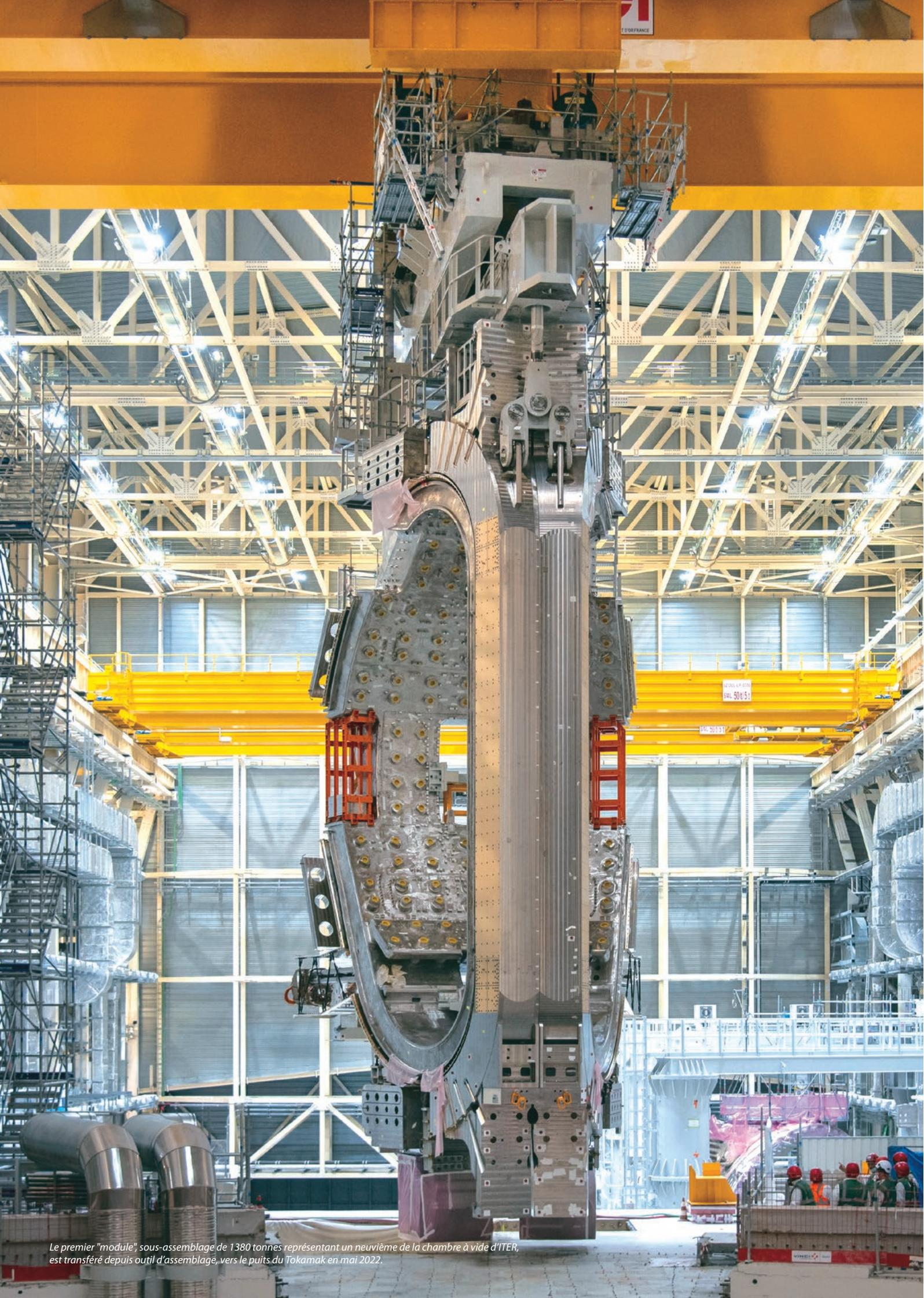
*Le premier "module", sous-assemblage de 1380 tonnes représentant un neuvième de la chambre à vide d'ITER, est transféré depuis outil d'assemblage, vers le puits du Tokamak en mai 2022.*
