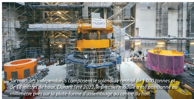
Six modules indépendants composent le solénoïde central de 1 000 tonnes et de 18 mètres de haut. Durant l'été 2022, le premier module a été positionné au millimètre près sur la plate-forme d'assemblage au centre du hall.
