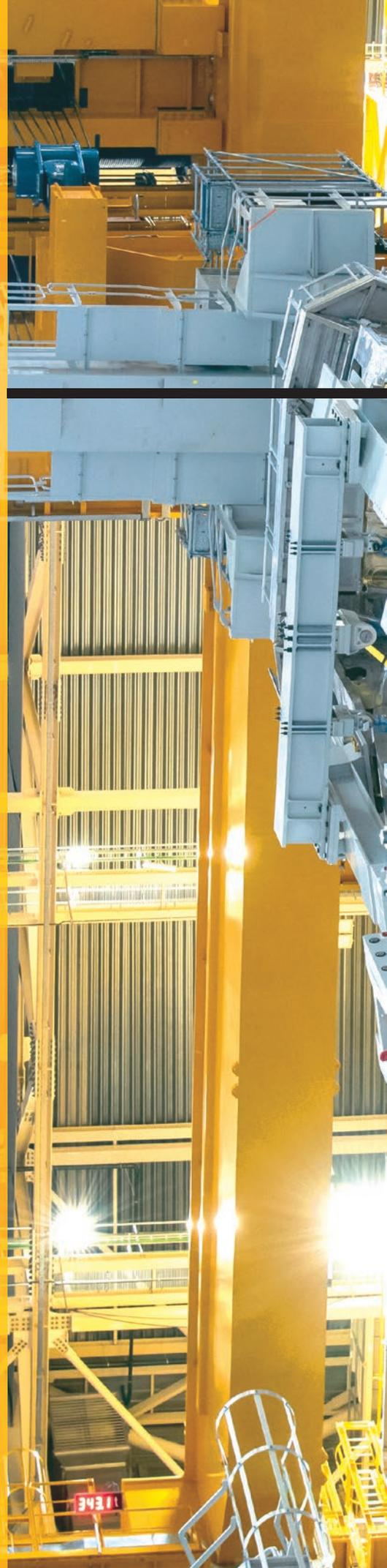
*Au mois de mai 2022, ITER réussit le transfert d'une première section de la chambre à vide (1 380 tonnes, 18 mètres de haut) dans la fosse du tokamak. C'est l'opération de levage la plus complexe réalisée jusqu'à ce jour.*
