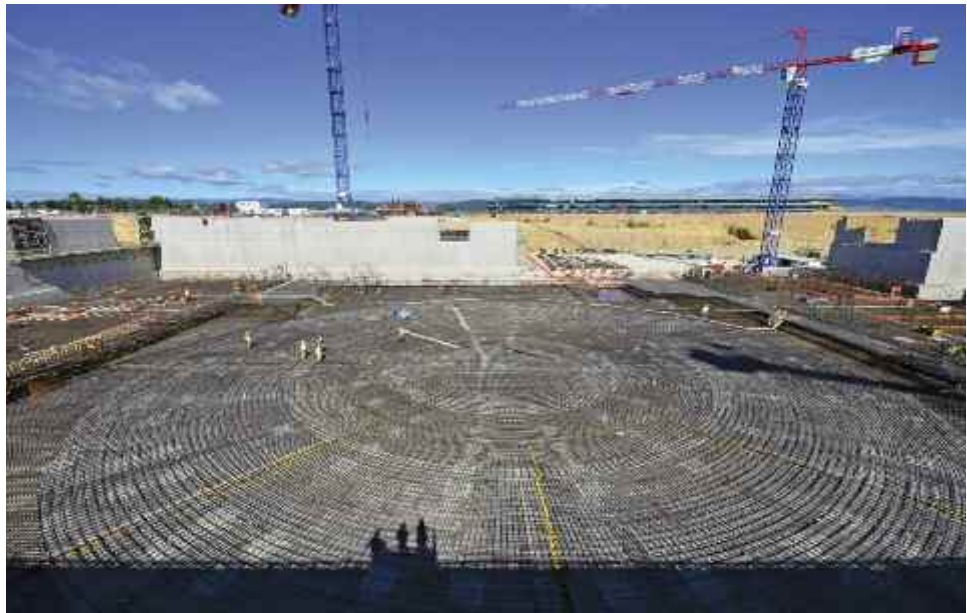
Vue générale du ferrailage du radier supérieur du Complexe tokamak. © ITER Organization
