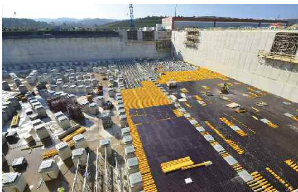
Coffrage du radier supérieur sur le Bâtiment diagnostics. © ITER Organization
