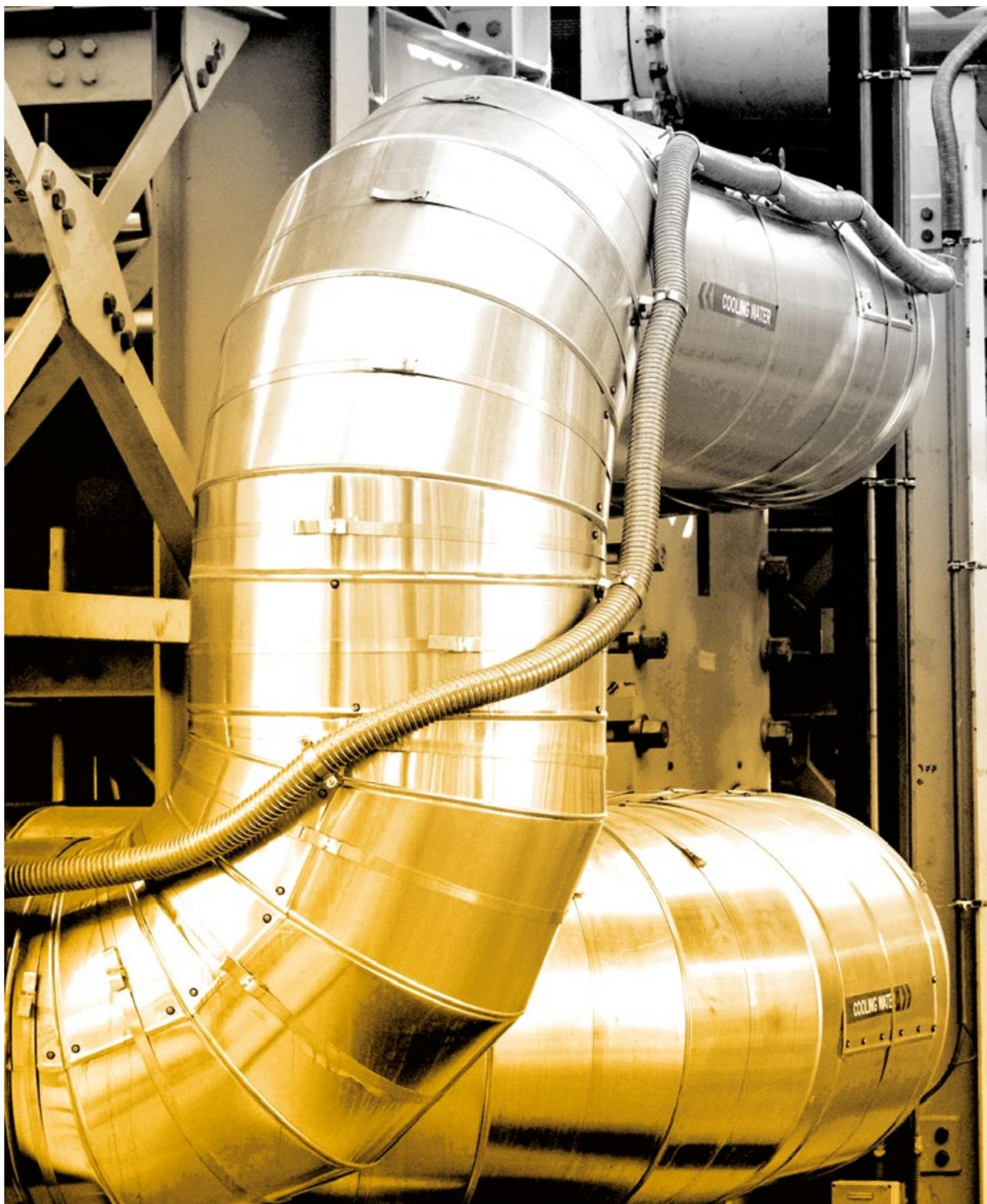
*Quelque 6 000 tonnes d'équipements ont pris place dans la zone de rejet thermique sur le nord de la plateforme ITER. Livrés par l'agence domestique indienne et installés par des sous-traitants de l'Organisation ITER, ces tuyaux, pompes, vannes, et échangeurs sont dimensionnés pour gérer un volume d'eau de refroidissement allant jusqu'à 7 700 mètres cubes par seconde. La prochaine étape sera la mise en service de l'ensemble.*
