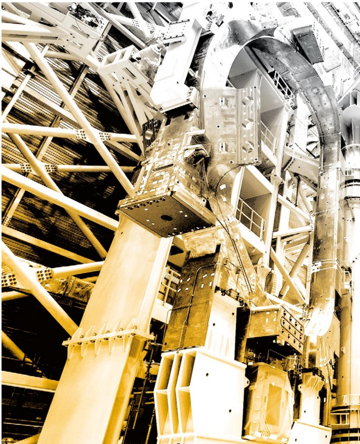
*Les éléments du premier sous assemblage sont en place : le secteur n°6 de la chambre à vide, déjà « habillé » par des panneaux d'écran thermique, et deux bobines verticales.*
