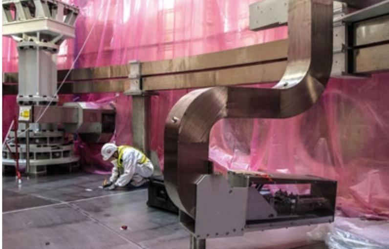
A gauche, un pilier de soutien pour la bobine annuaire PF5. A droite, une ligne d'alimentation pour les bobines de correction, qui fera cheminer du fluide cryogénique et de l'électricité jusqu'aux aimants.
