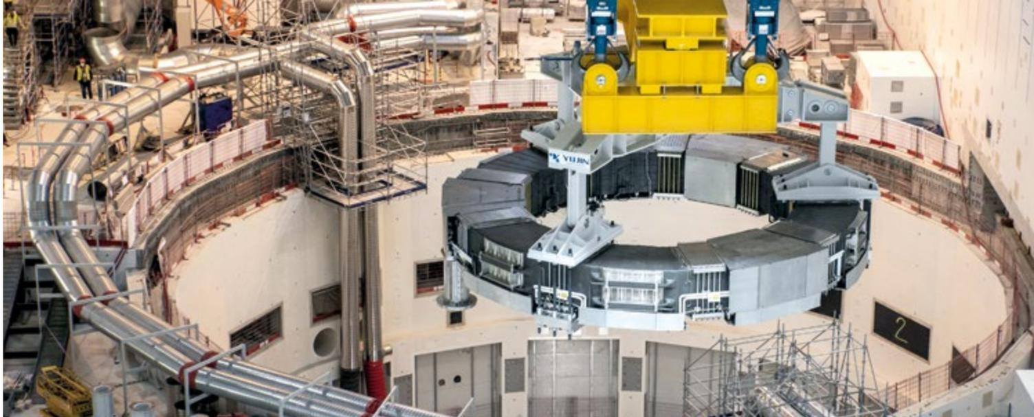
Cette bobine annulaire de 400 tonnes (PF6) est le premier élément du système magnétique à être transportée jusqu'au puits du tokamak. La bobine restera plusieurs années sur des supports temporaires, jusqu'à l'assemblage complet de la chambre à vide. Elle pourra alors être alignée et installée définitivement.
