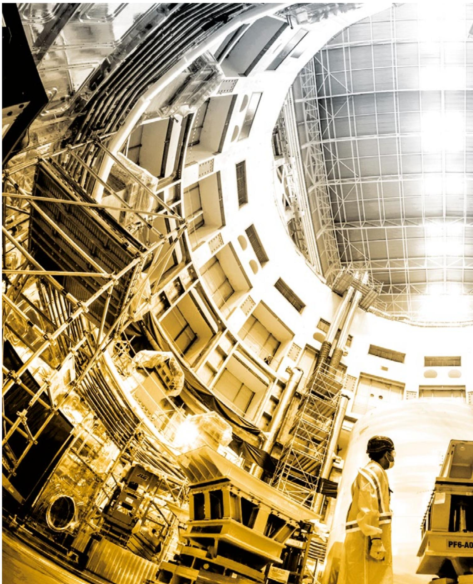
*L'assemblage s'opère du bas vers le haut. Les opérations ont débuté par la base du cryostat, l'élément le plus lourd, pesant 1 250 tonnes. Elles se poursuivront avec la partie inférieure du cryostat, les neuf modules de la chambre à vide constituant chacun une section de 40°, la partie supérieure du cryostat, et en dernier lieu, le couvercle de la machine.*
