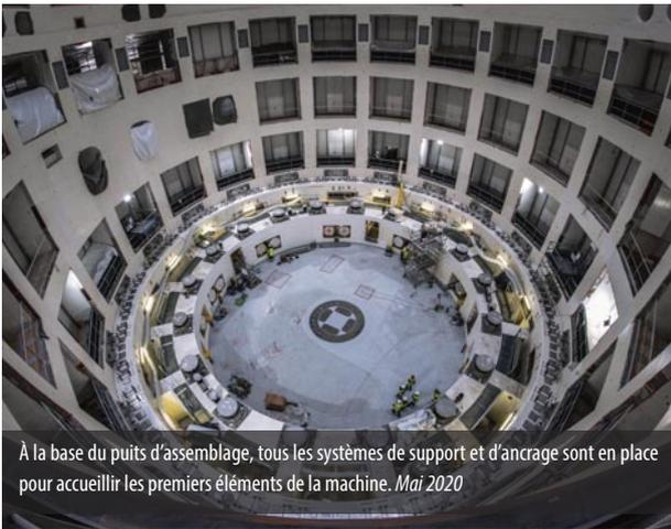
À la base du puits d'assemblage, tous les systèmes de support et d'ancrage sont en place pour accueillir les premiers éléments de la machine. *Mai 2020*
