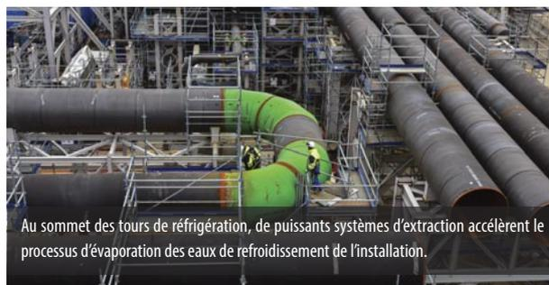
Au sommet des tours de réfrigération, de puissants systèmes d'extraction accélèrent le processus d'évaporation des eaux de refroidissement de l'installation.
