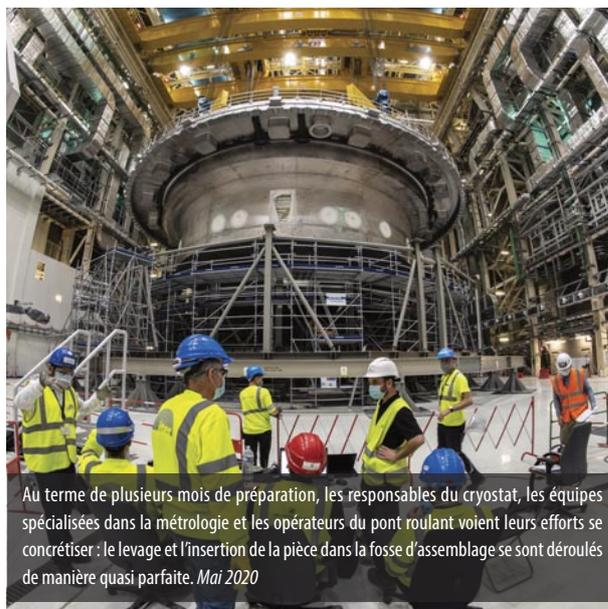
Au terme de plusieurs mois de préparation, les responsables du cryostat, les équipes spécialisées dans la métrologie et les opérateurs du pont roulant voient leurs efforts se concrétiser : le levage et l'insertion de la pièce dans la fosse d'assemblage se sont déroulés de manière quasi parfaite. *Mai 2020*
