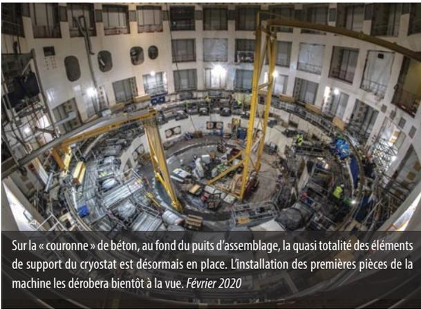
Sur la « couronne » de béton, au fond du puits d'assemblage, la quasi totalité des éléments de support du cryostat est désormais en place. L'installation des premières pièces de la machine les dérobera bientôt à la vue. Février 2020
