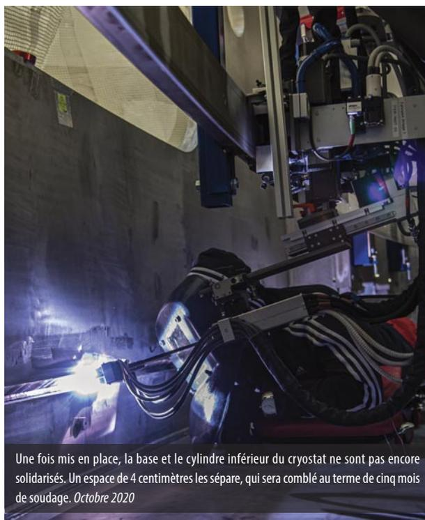
Une fois mis en place, la base et le cylindre inférieur du cryostat ne sont pas encore solidarisés. Un espace de 4 centimètres les sépare, qui sera comblé au terme de cinq mois de soudage. Octobre 2020
