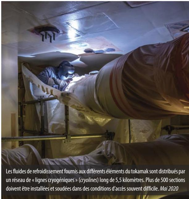
Les fluides de refroidissement fournis aux différents éléments du tokamak sont distribués par un réseau de « lignes cryogéniques » (cryolines) long de 5,5 kilomètres. Plus de 500 sections doivent être installées et soudées dans des conditions d'accès souvent difficile. Mai 2020
