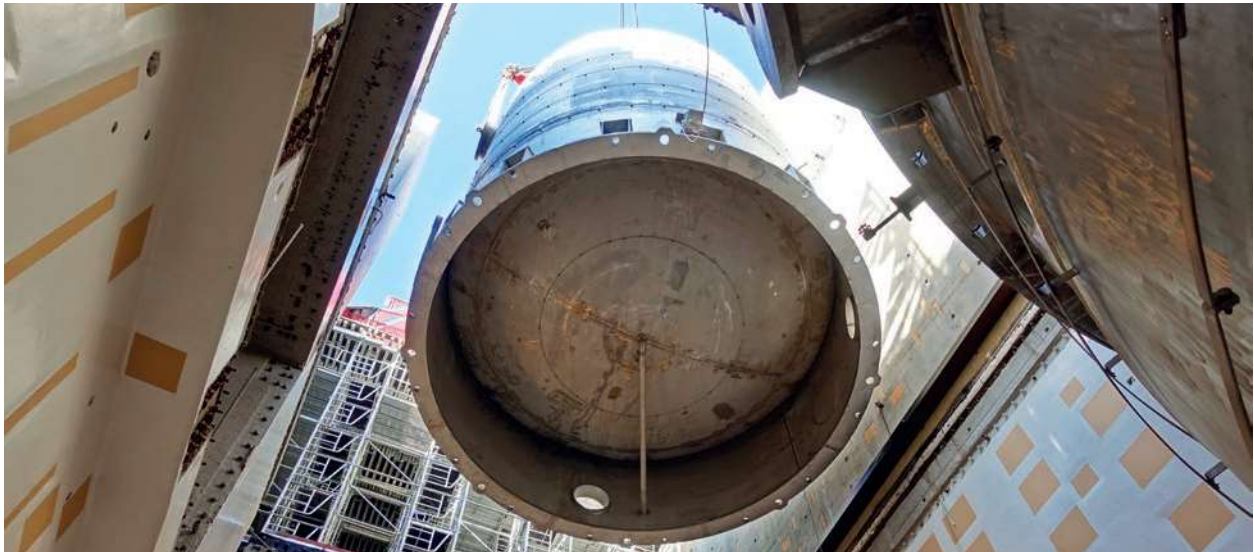
Trois cuves du système de refroidissement (fournies par les États-Unis) et quatre autres destinées au système de décharge ont été introduites dans le bâtiment tokamak au travers de cette étroite ouverture. Août 2018.
