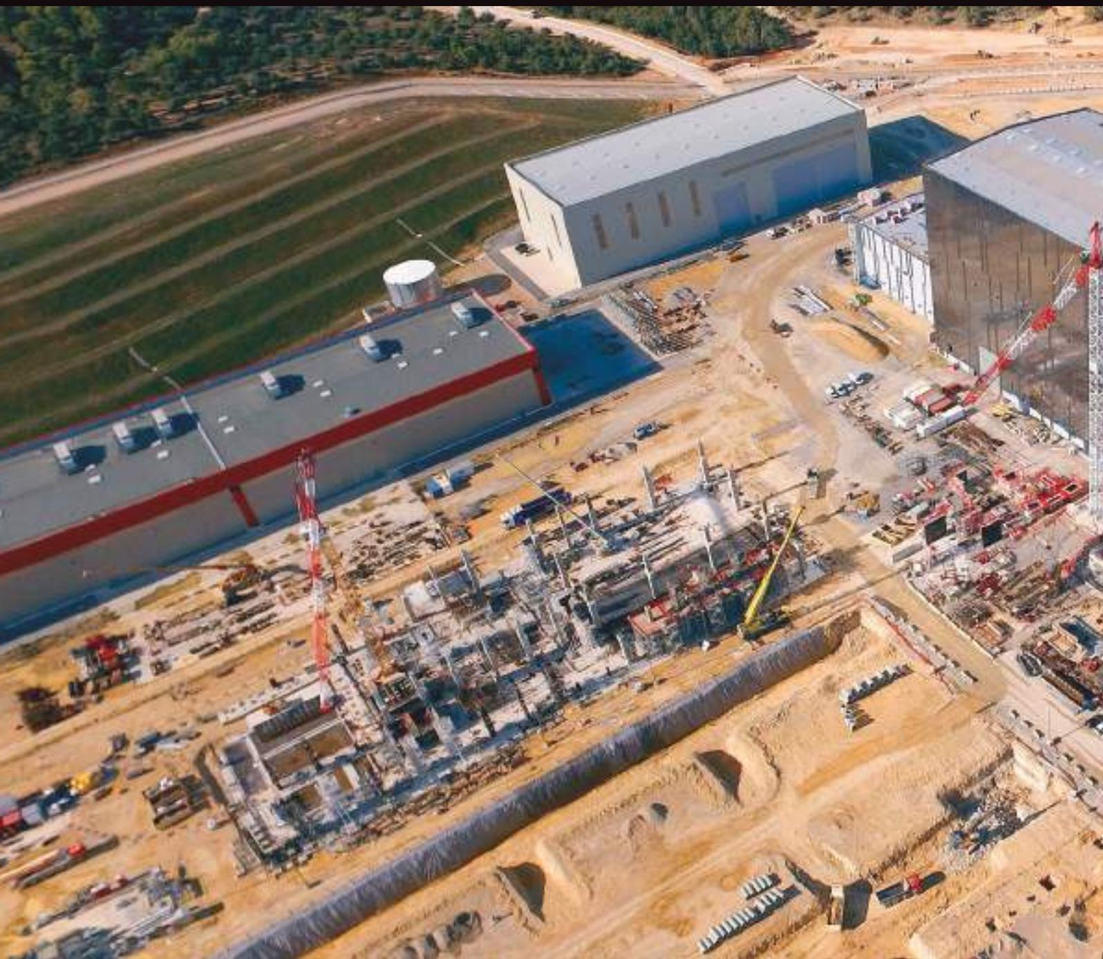
*Vue aérienne de la plateforme avec au premier plan à droite les travaux en cours sur le Complexe tokamak, le Hall d'assemblage dans son prolongement sur la gauche, précédé de l'Atelier cryostat.*
