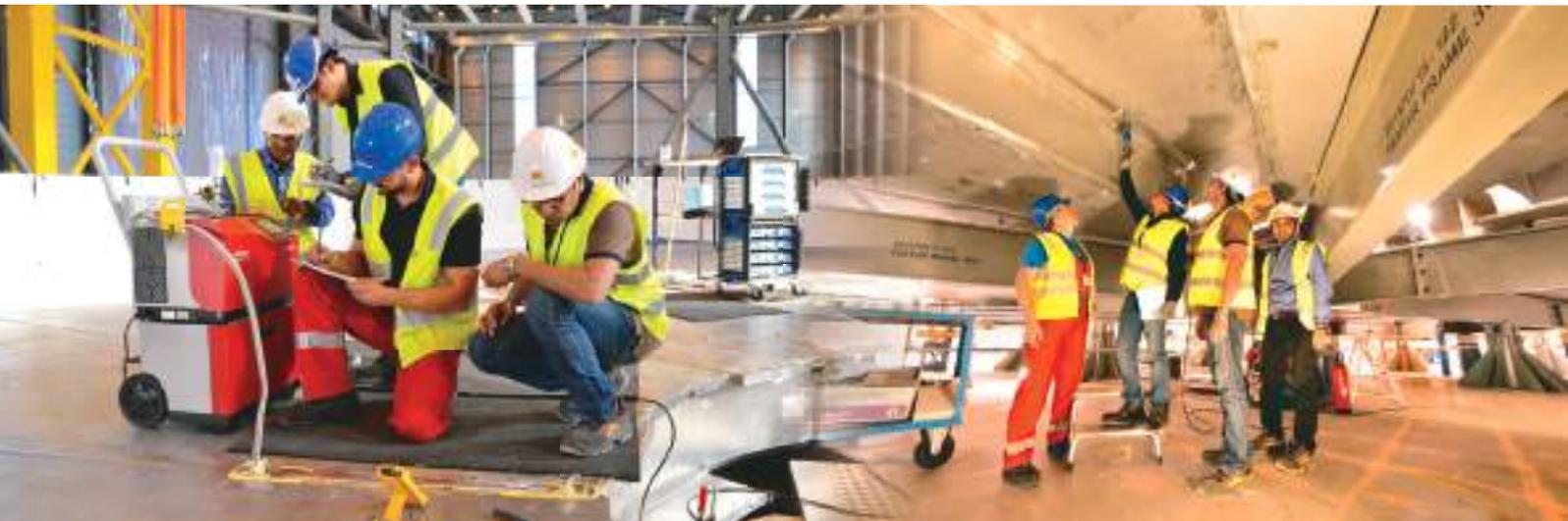
Contrôles techniques des soudures du cryostat. ©ITER Organization
