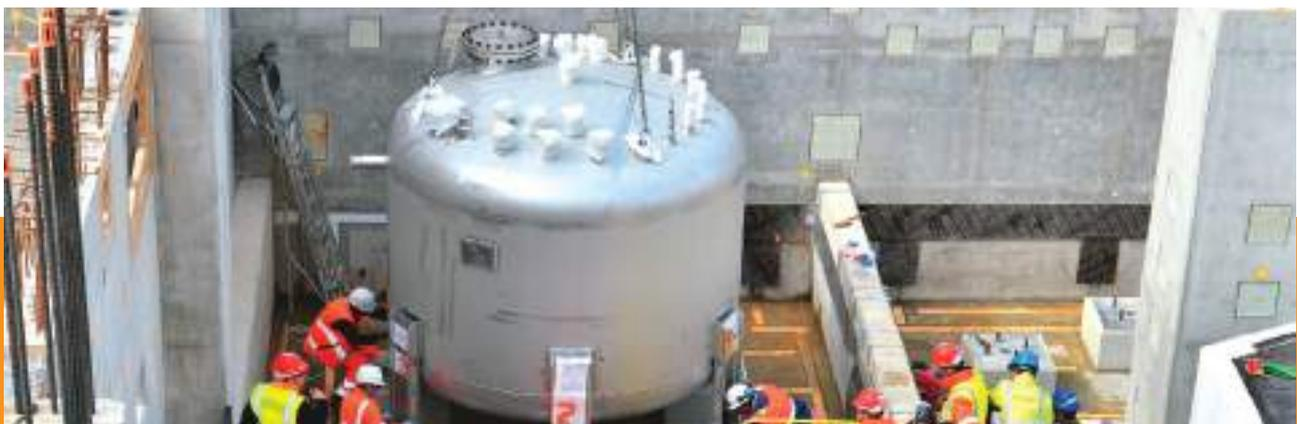
*Séquences de l'installation de l'une des six cuves pour le système de détritiation d'eau, dans le deuxième sous-sol du Bâtiment tritium (niveau B2), avril 2016.*
