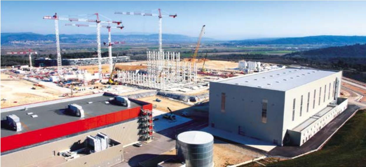
Vue du site de construction avec au premier plan à droite le Bâtiment d'assemblage du cryostat, et à gauche le Bâtiment d'assemblage des bobines poloïdales. Contre le mur de ce bâtiment, se trouvent ses tours de refroidissement, avril 2015.
