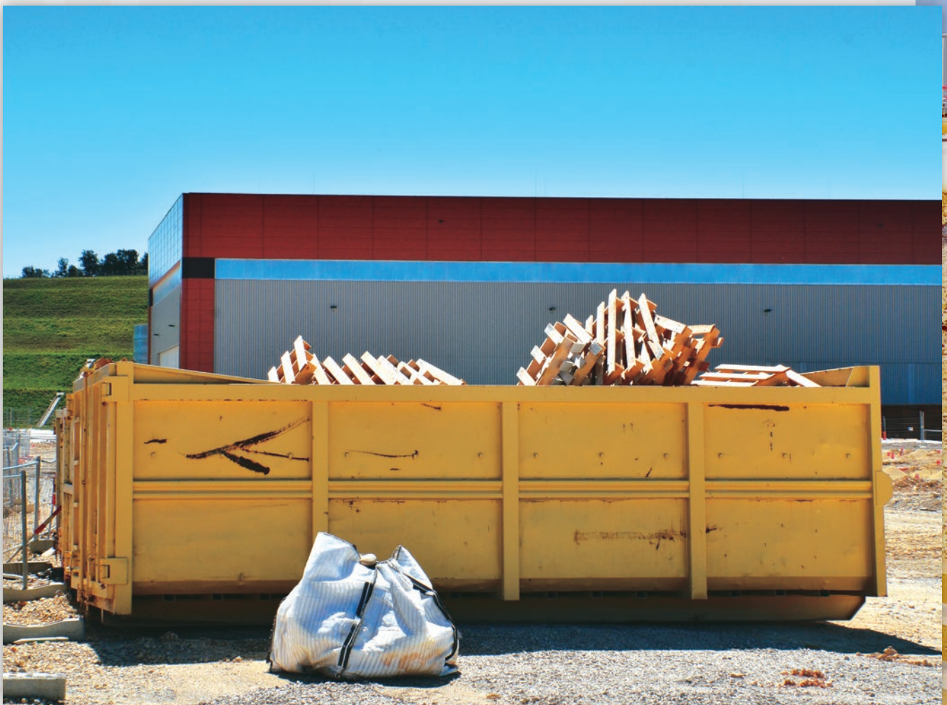
Bennes de déchets sur le site de construction. À l'arrière-plan, le Bâtiment de construction des bobines poloidales. © ITER Organization
