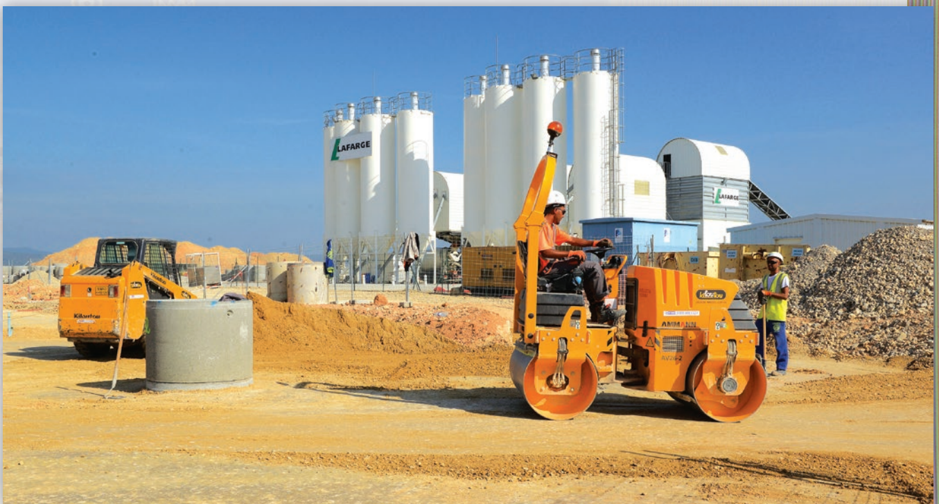
Centrale à béton sur le chantier d'ITER. © ITER Organization
