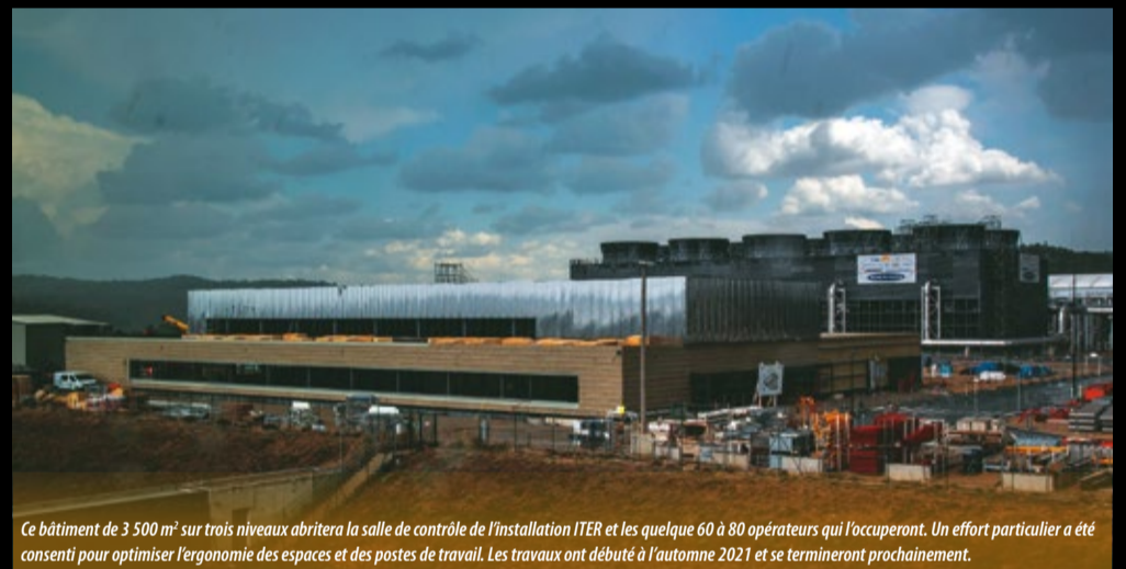
Progressivement, les différents systèmes industriels de l'installation sont mis en service. Ici, l'usine cryogénique qui gère et distribue les fluides de refroidissement destinés au système magnétique supraconducteur, aux écrans thermiques et aux cryopompes du Tokamak (septembre 2022).
